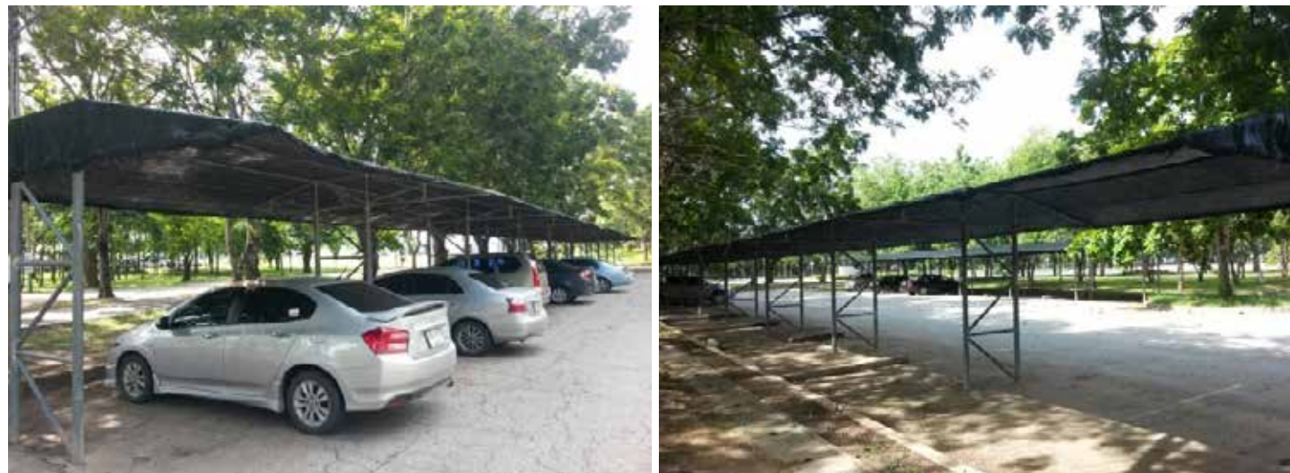
7. เปลี่ยนแอสหลังคาที่จอดรถยนต์หน้าคณะตรุใกล้สระประพิจรุณ 4 หลัง รวมพื้นที่ 750 ตารางเมตร -พื้นที่กว้าง 5 เมตร ยาว 46 เมตร 2 หลัง 460 ตารางเมตร -พื้นที่กว้าง 5 เมตร ยาว 29 เมตร 2 หลัง 290 ตารางเมตร
